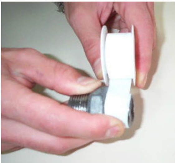
Metodo de aplicacion de cintas de PTFE Teflon
